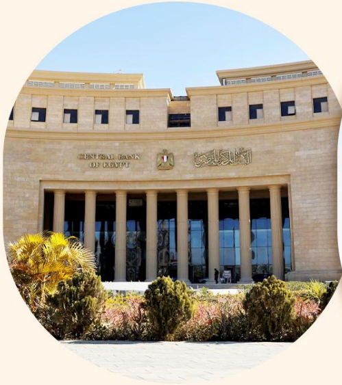
-埃及银行大楼-
